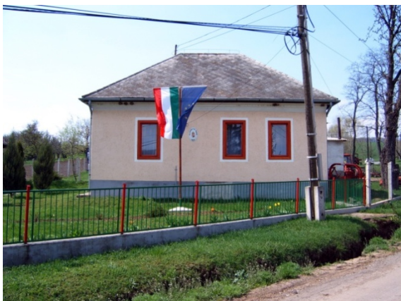
48. kép Önkormányzat épülete
