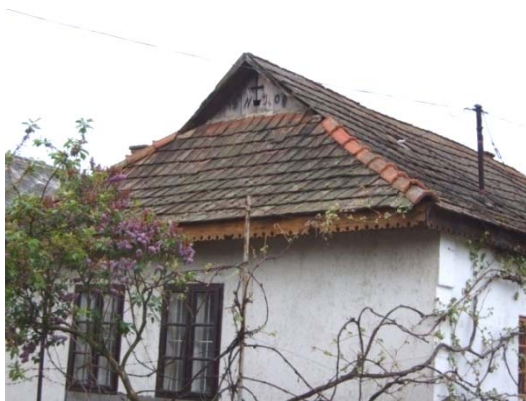
38. kép Kontyolt tető
